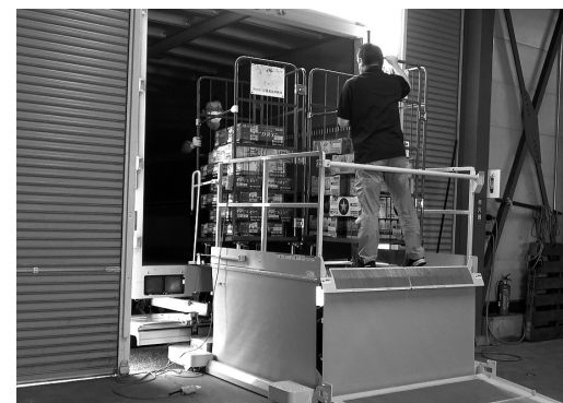
写真.9 移動式段差解消用シザーリフト
